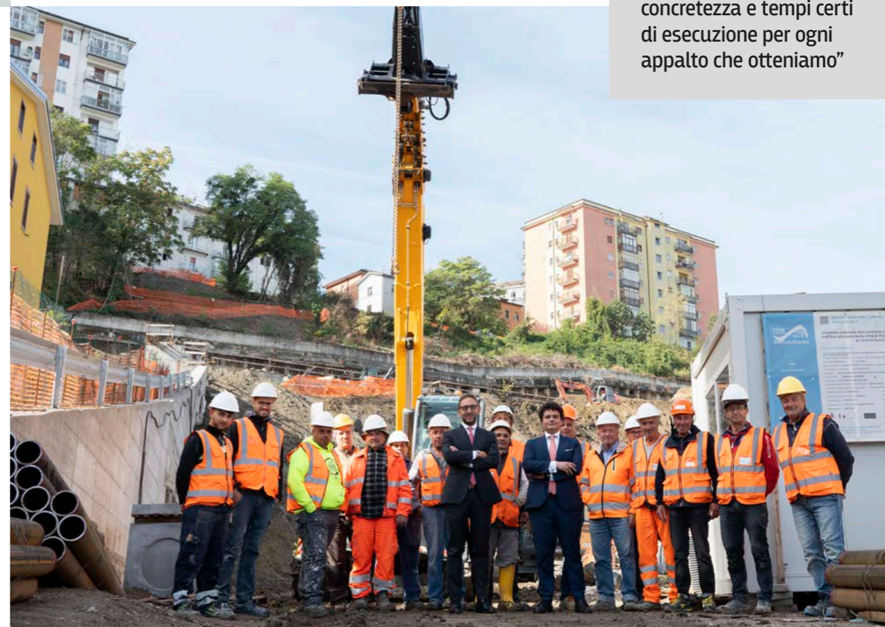
Parte del team operativo impegnato nella costruzione, per Conto del Comune di Potenza, dell'impianto pedonale meccanizzato per la riduzione del traffico veicolare della città di Potenza
